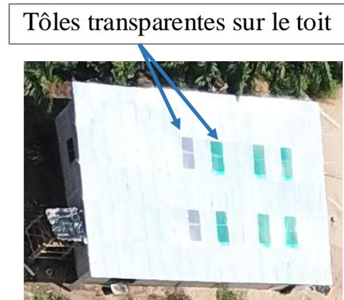
Vue de dessus d'une écloserie avec toiture disposant de tôles transparentes
