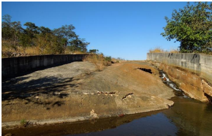
破損した洪水吐
