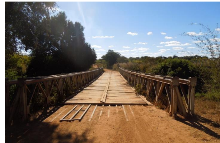
損傷の程度が大きいFB内の橋梁
