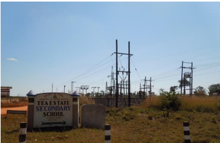
FB前の変電所 (送電網は限定的)
