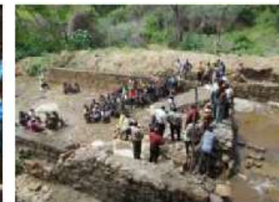
頭首工の施工
