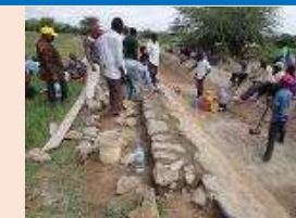
農民参加型補修工事
