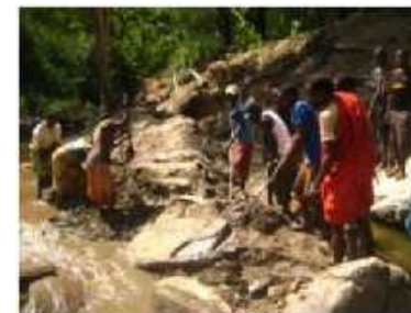
河川締め切り工事
