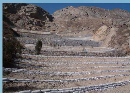
写真11 四川省森林造成施工中
