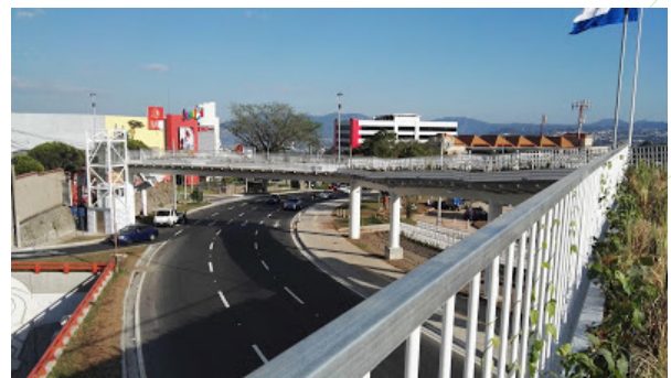
Pasarela del Redondel Masferrer, San Salvador.
