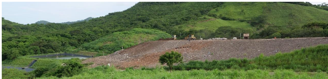
写真 7-29 フェーズ3 埋立地全景
