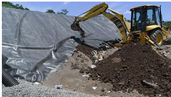
写真 7-18 覆土の敷設の実践
