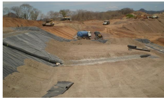
写真 7-17 建設中の衛生埋立処分場 (フェーズ2)
