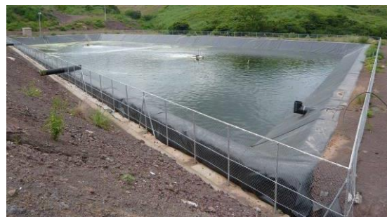
写真 7-19 浸出水貯水池でのエアレーター使用の様子
