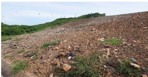
写真 7-27 フェーズ3 埋立地（下部）
