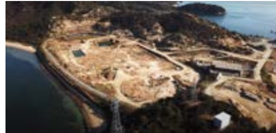
写真 5-4 上空から見た不法投棄現場 (2021年11月)
