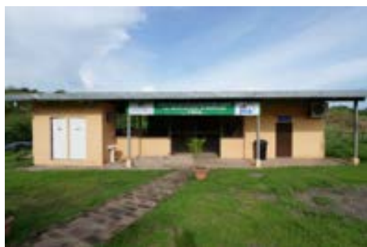
写真 7-32 講義などを行う教育棟 （処分場敷地内）
