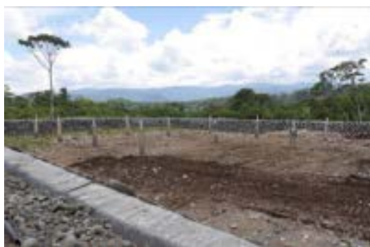
写真 4-72 福岡方式処分場外観
