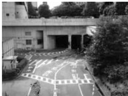
写真 6-9 杉並清掃工場専用地下道路 (1982年)
