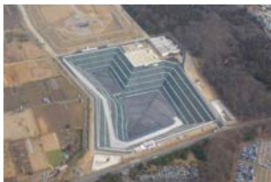
写真 4-66 相模原市一般廃棄物最終処分場
