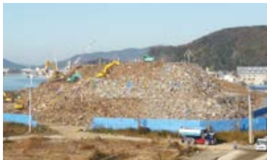
写真 5-11 一次仮置場の状況 (石巻市：2012年11月)
