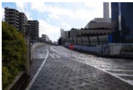
写真 4-32 収集車両の出入口
