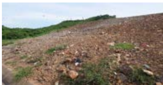
写真 7-27 フェーズ 3 埋立地（下部）
