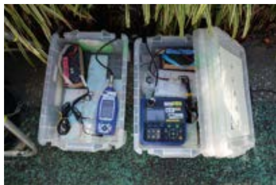
写真 1-12 設置される騒音計と振動計
