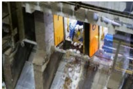
写真 4-35 ①プラットホーム (ごみピット側)
