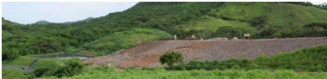
写真 7-29 フェーズ 3 埋立地全景
