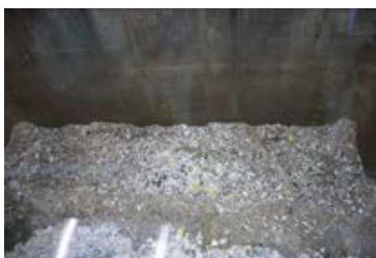
写真 4-36 ②ごみピット
