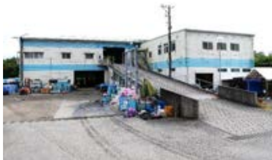
写真 6-36 そおりサイクルセンター外観
