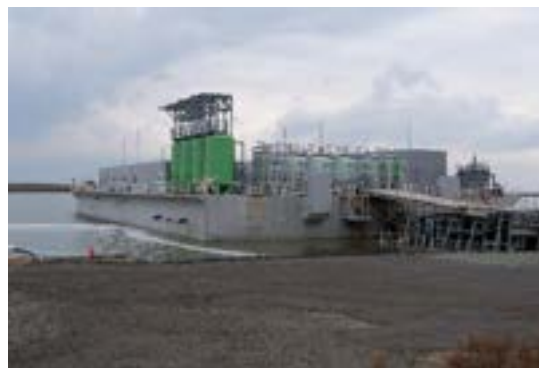
写真 2-13 処分場内に設置されている水 処理施設 (大阪沖埋立処分場)
