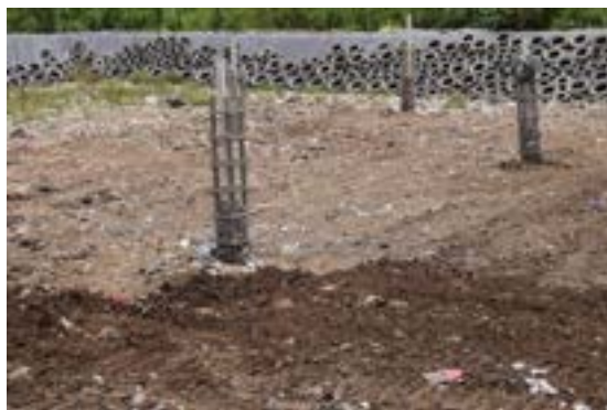
写真 4-73 福岡方式処分場ガス抜き管
