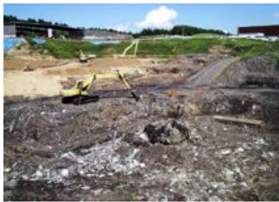
写真 5-8 廃棄物の掘削（2012年）
