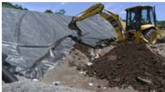
写真 7-18 覆土の敷設の実践
