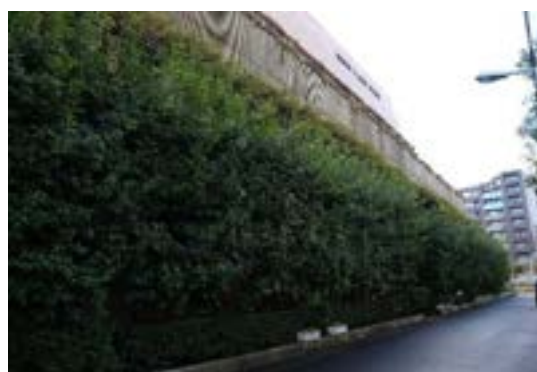
写真 4-31 緑化された工場外壁
