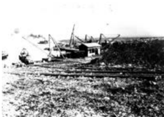
写真 4-54 中間処理しない直接埋立で、覆土が十分に施されていないため自然発火している埋立状況（1957年頃）
