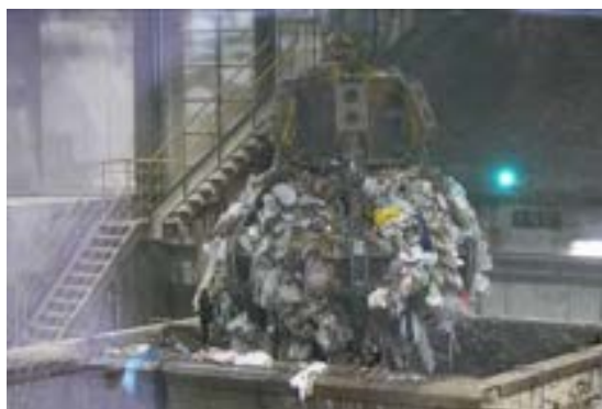
写真 4-38 ③ごみクレーン
