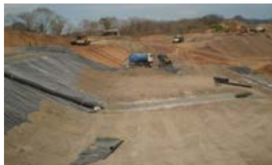
写真 7-17 建設中の衛生埋立処分場 (フェーズ 2)
