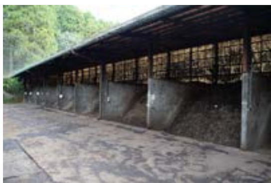
写真 6-31 コンクリートの堆肥化ヤード
