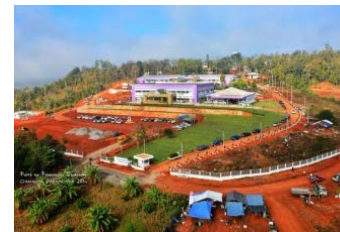
山を切り開き移設された チェンマイ県メーチェム郡病院遠景
