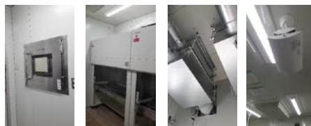
奈良県で組み立て中のラボ、完成後海を越えてガボンへと運ばれる予定。
