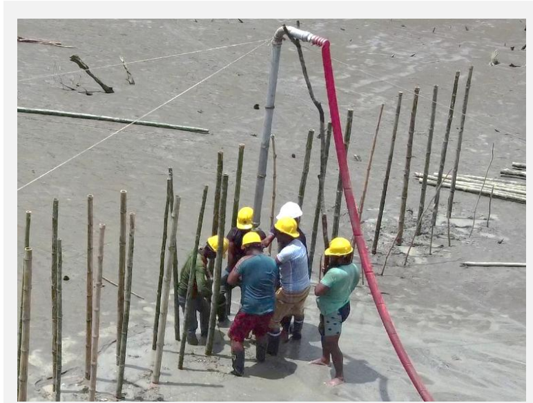
水ジェットによる竹製消波柵の主柱設置(2026年8月)
