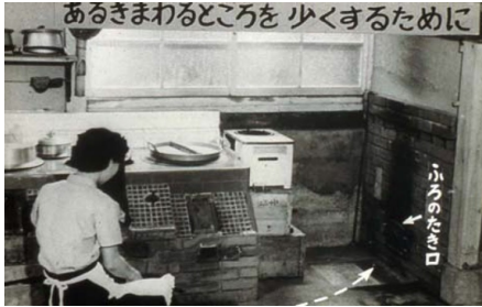
(上) 歩き回る所を少なくするため、かまどと風呂の焚き口を近くする (出典:農山漁村文化協会(1957)、スライド「農家の住まいの改善」)
