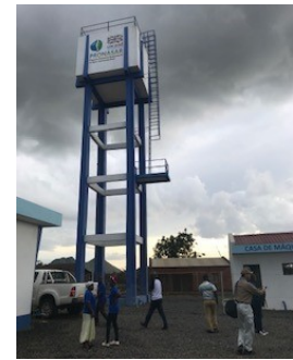
(写真2) 既存の管路給水施設の給水塔。四角いタンクへポンプで揚水された水が重力で配水されていく。
