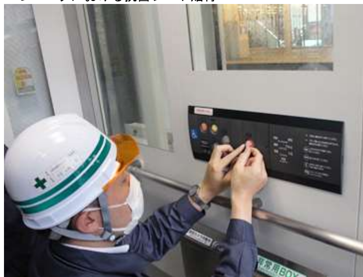
エレベータにおける抗菌シート貼付
