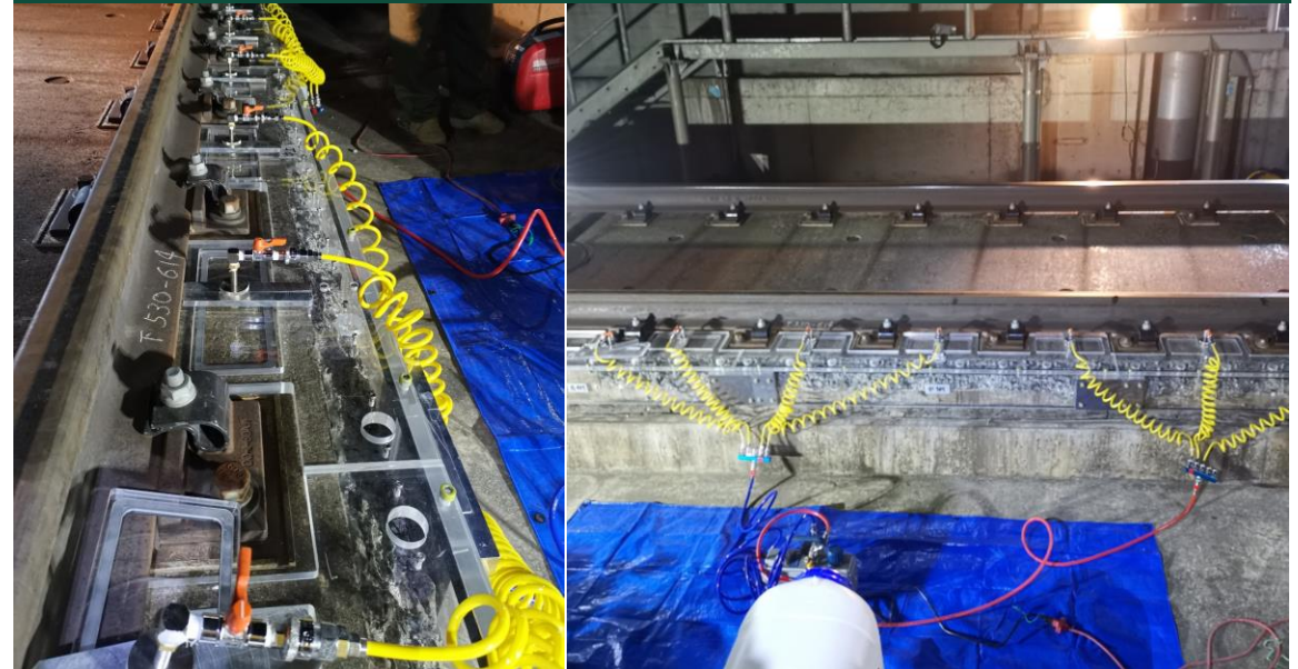
短時間施工を可能にした断面修復装置
