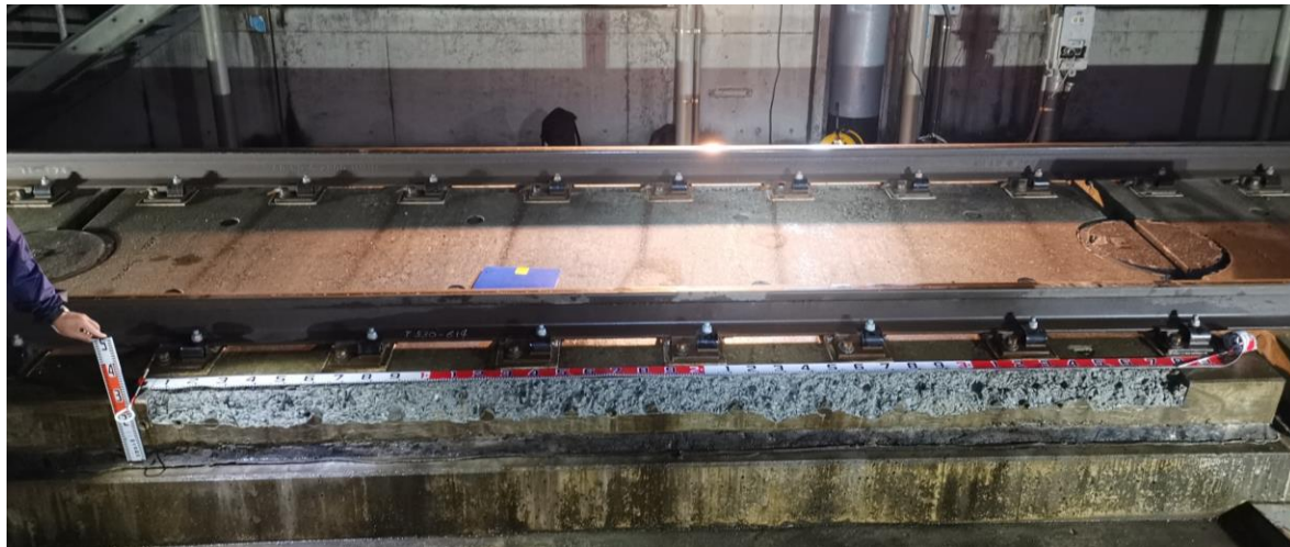
WJによる劣化部のはつり（時間短縮と高品質を両立）
