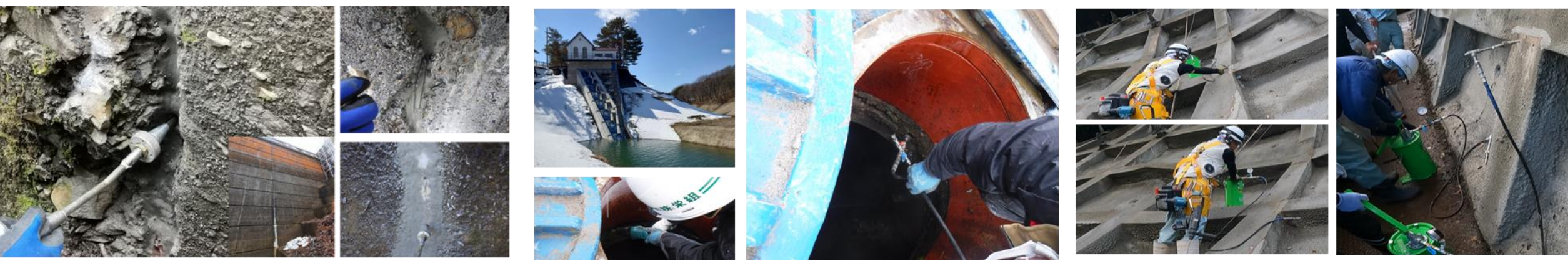
ノズル型圧力調整注入工法
