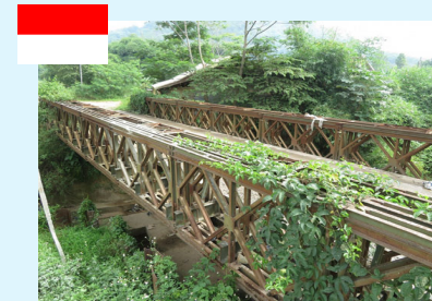
地方部のベイリー橋
