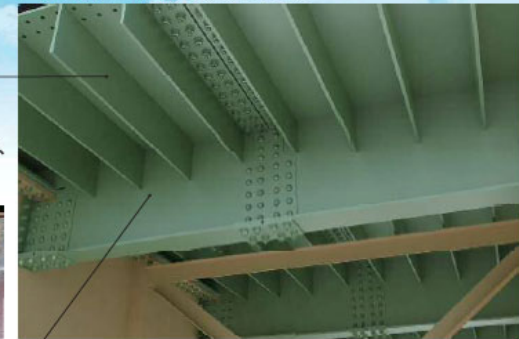
鋼床版パネル縦・横リブ交差部
