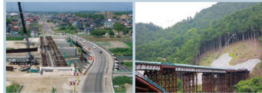
橋梁架け替え用の迂回路として 工事用道路の仮橋として
