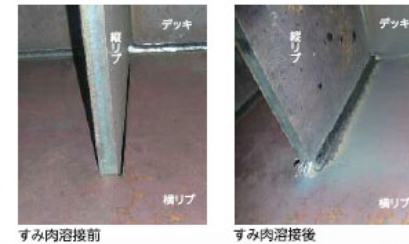
主桁-鋼床版パネル接合部(案)
