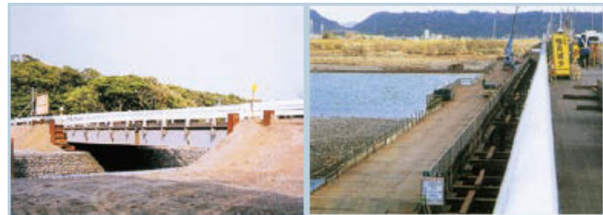
災害時の応急橋として 重機作業用の仮栈橋として
