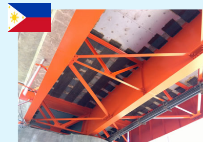
床版下面へのFRP・鋼板接着
