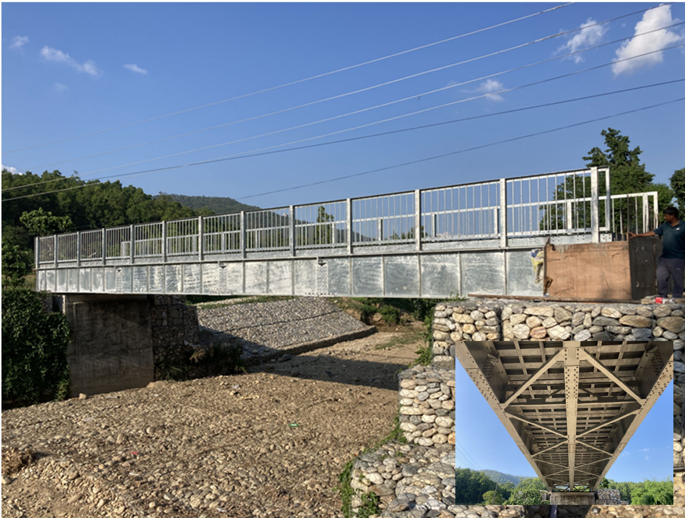
鋼桁タイプ「PABRIS」の海外適用事例 (新設橋梁、Lタイプ桁、橋長24.0m × 幅員4m)
