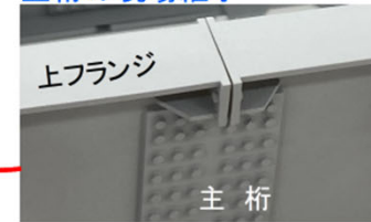
主桁の現場継手
