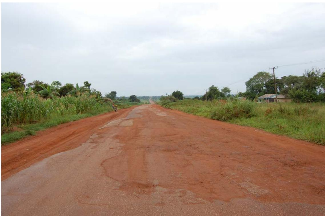
注：アスファルト舗装が劣化し剥がれている。
