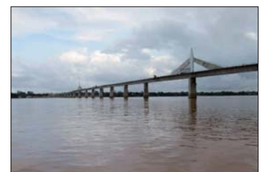
2006年12月に開通した第二メコン国際橋 (写真提供 山九株式会社)
