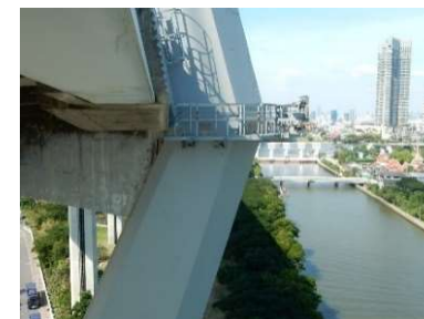
路面から桁下への通路
