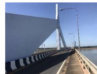
タイ・ラオス友好橋
