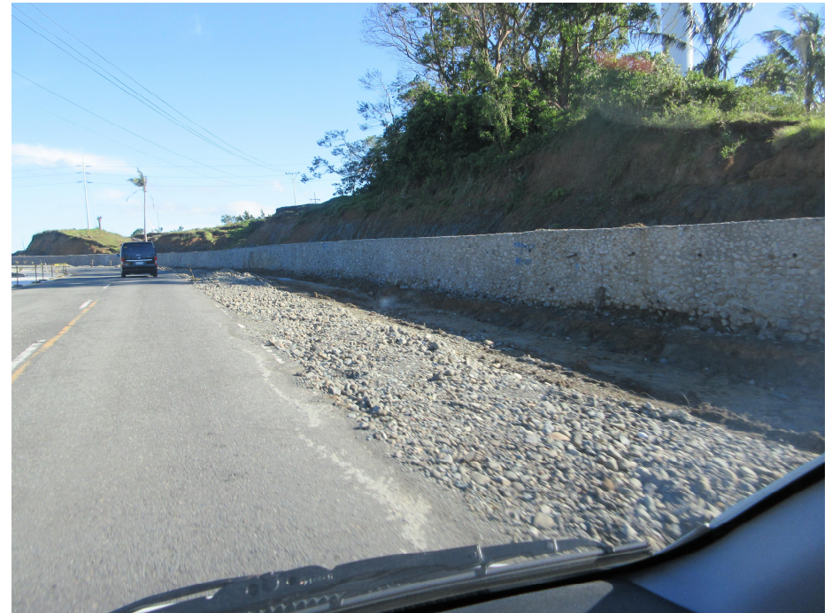
4車線拡幅舗装の状況
