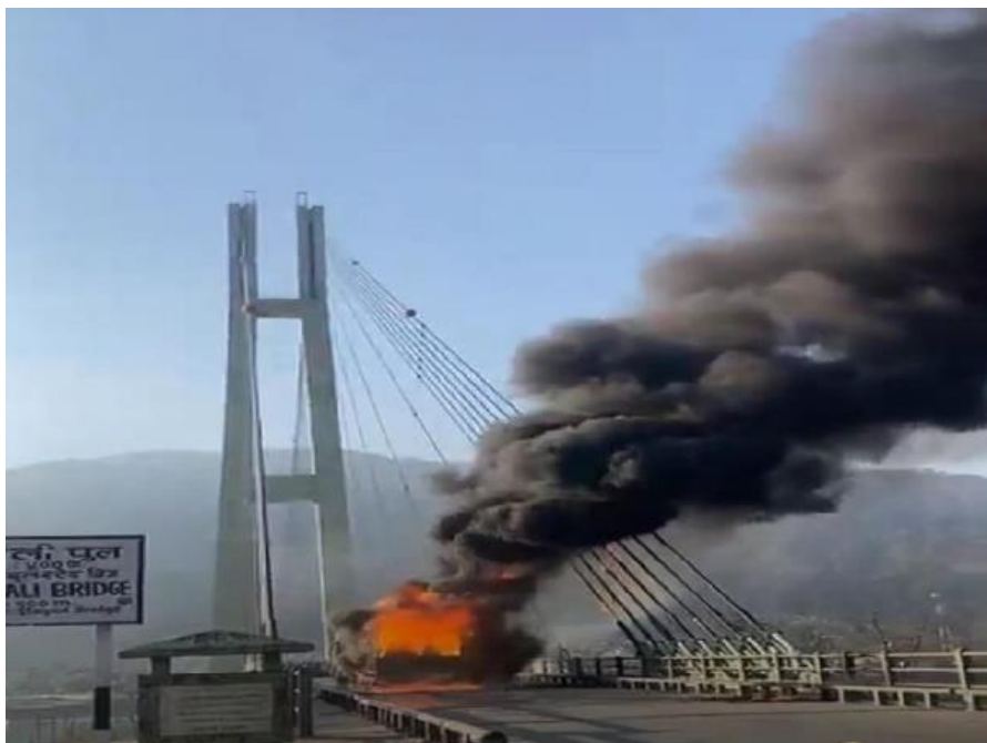
斜長橋の火災によるケーブル損傷状況
