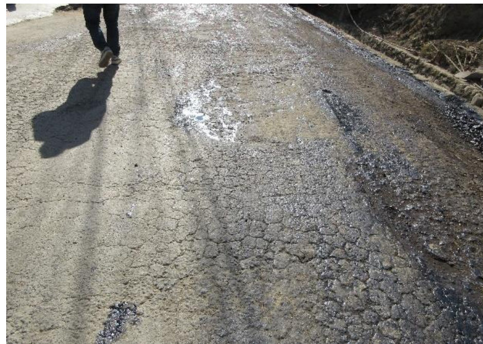
アスファルト舗装の損傷状況
