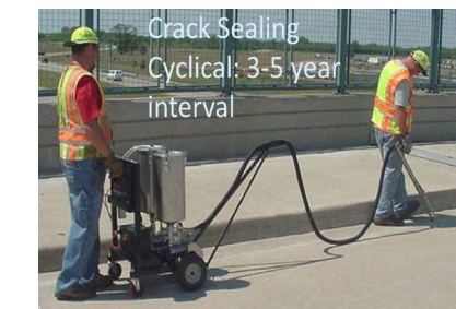
橋面ひび割れ注入
