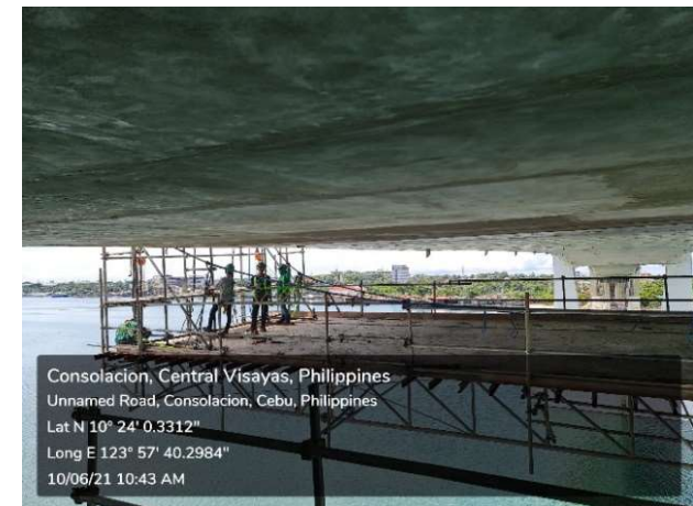
主桁下面ASR対策
