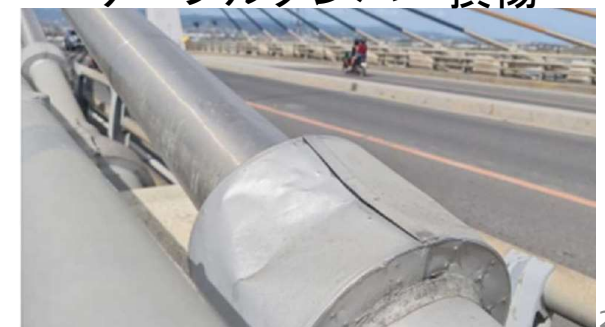
ケーブルダンパー損傷
