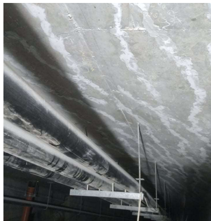
箱桁内クラック補修
