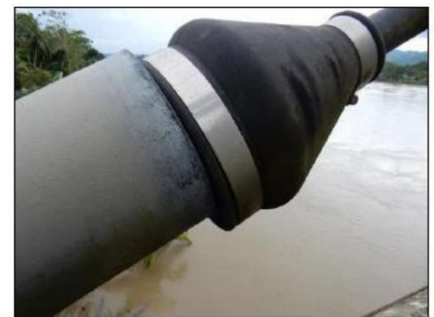
止水ゴムカバーの変形回転
