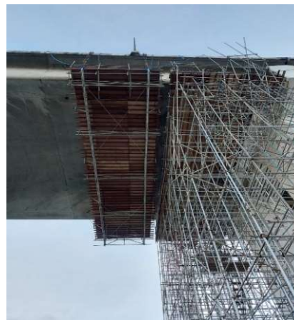
足場工設置状況
