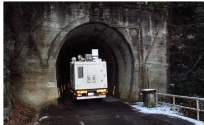
Bトンネル(空洞レーダ)
