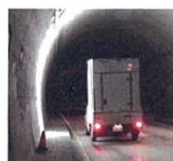
走行型高精細画像計測システム （トンネルトレーサー）
