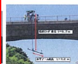
「橋梁点検カメラシステム 視る・診る」による近接目視、 打音調査等援助・補完技術
