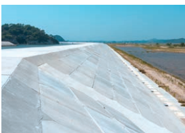
防波堤(湾岸施設)
