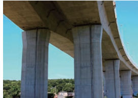
橋梁(床版・橋脚)
