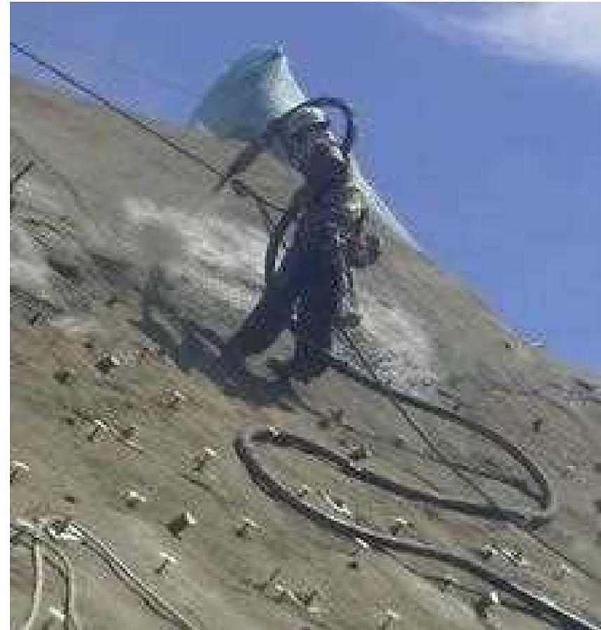
老朽化した吹付材をはつり取らず対策
