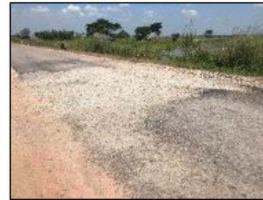
大規模な損傷
