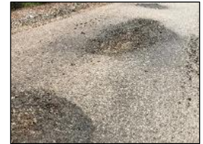
損傷補修箇所の再損傷
