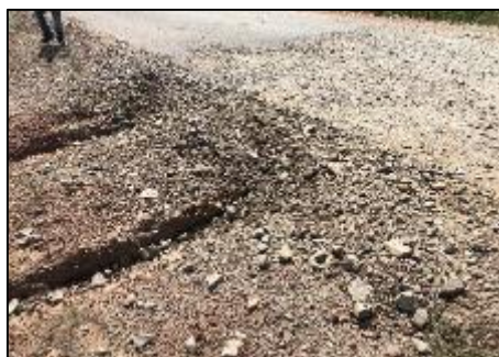
降水量の多い地域で 舗装の劣化が発生
