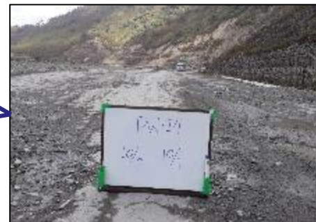
標高が高く、気温の低い 地域で舗装の劣化が発生
