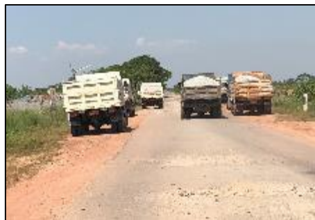
交通量の多い地域で 舗装の劣化が発生
