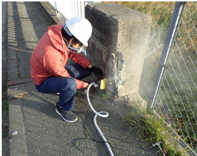
粉塵が出ている状況
