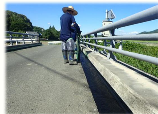
橋面端部の簡易橋面防水
