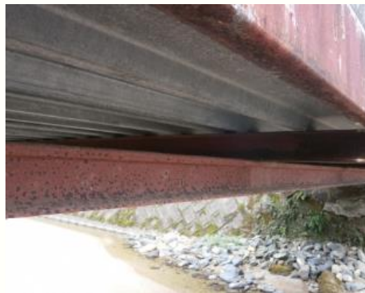
鉄道のレールを橋に 流用 (里道橋)
