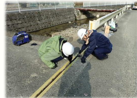
伸縮装置の漏水補修
