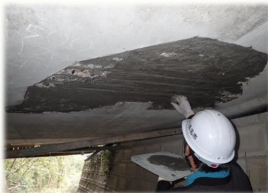
断面修復（左官工法）
