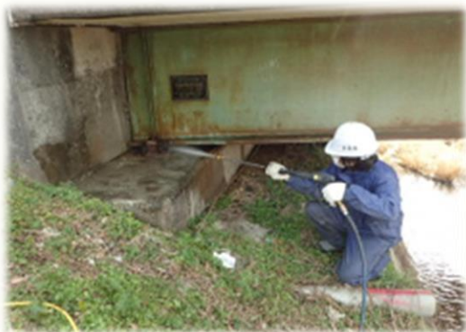
清掃（支承や橋面）
