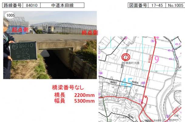
道路網図に表記のない市道橋の事例
