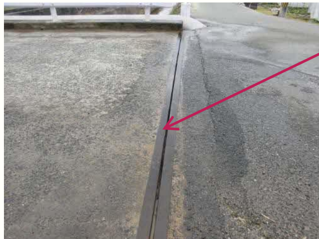
修繕前に清掃した状況
