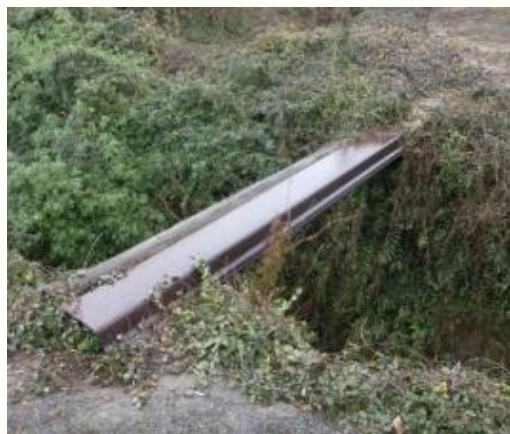
鋼矢板を橋に流用 (個人の橋)
