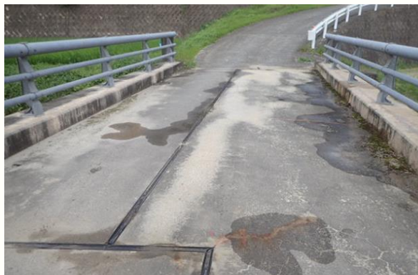
漏水が疑われる箇所に実証
