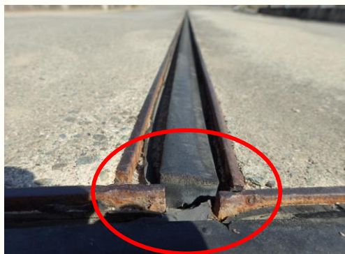
漏水が顕著な箇所
