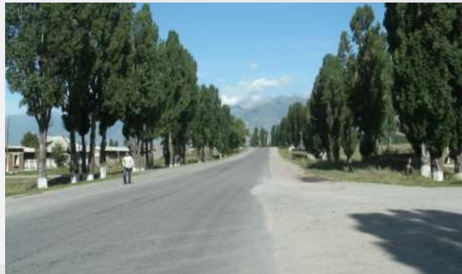
補修されず端から消えていく舗装（キルギス）
