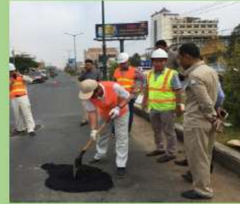
常温合材を用いたポットホール 補修(穴埋め、切削)を指導
