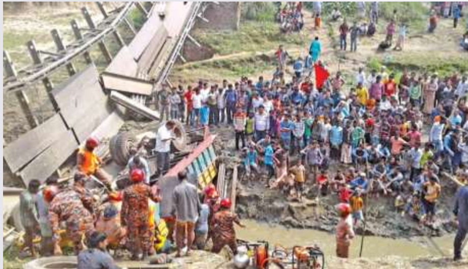
2018年2月15日に Bangladesh 国 Sunamganj で発生した落橋事故。
