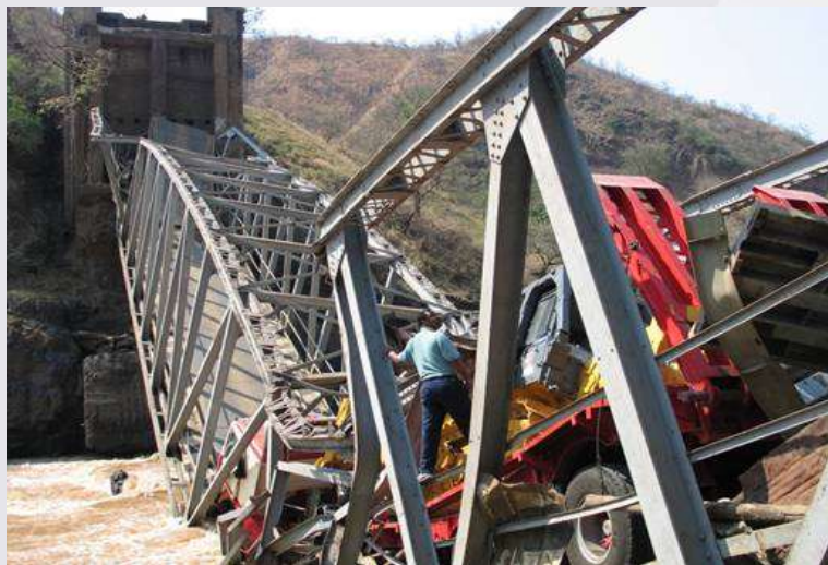
橋梁の崩落（エチオピア）(出典：JICA専門家)
