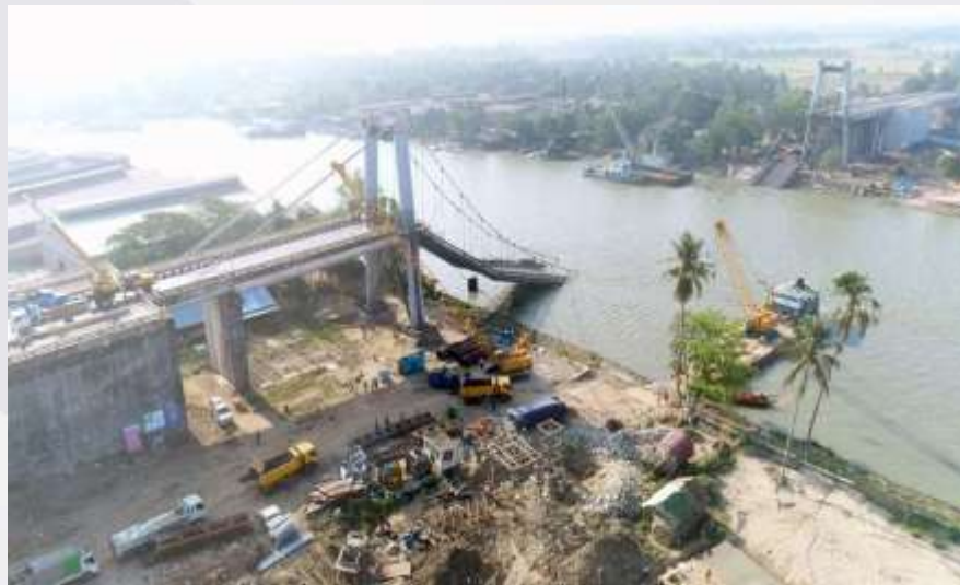
主ケーブルの腐食破断によるMyaungmya橋の崩落（ミャンマー2018年）(出典：東京大学)
