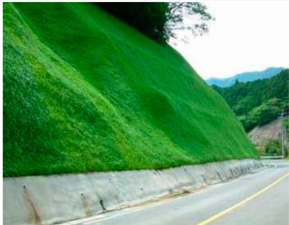
ローピングウォール工法 (連続繊維補強土工)(ライト工業)
