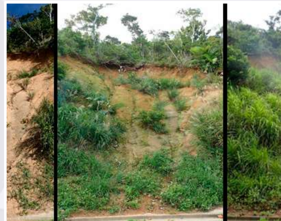
土壌藻類を用いた表面侵食防止法 (BSC法生物土壌クラスト 日本工営)
