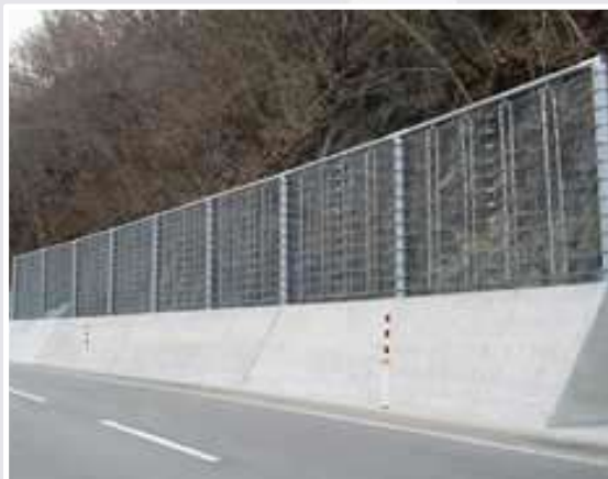
ループバリアー (高エネルギー吸収型 落石防護柵)(ゼニス羽田(株))
