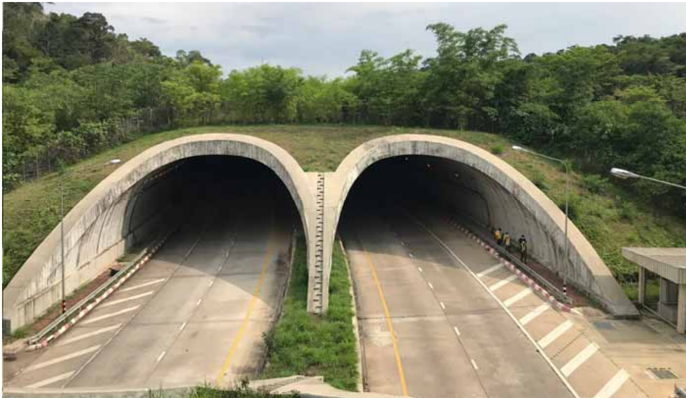
環境保全を目的としたトンネル (Wildlife Corridor)
