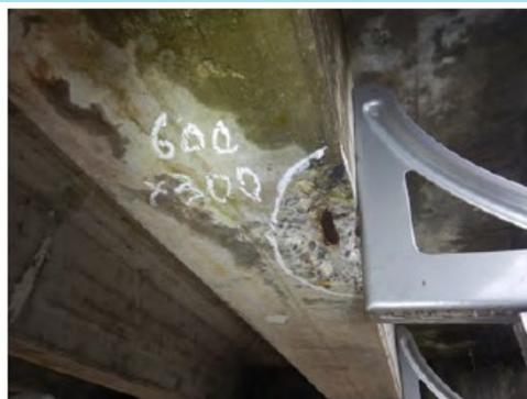
下部工のひびわれ、欠損、剥離、鉄筋露出
