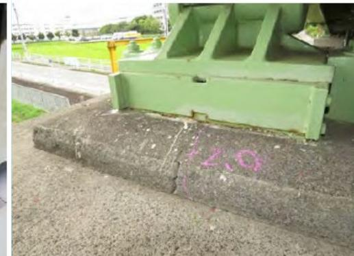
主桁の剥離、鉄筋露出
