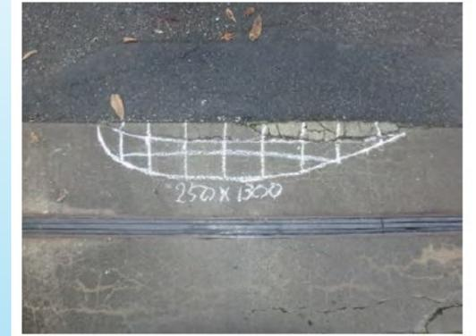
壁高欄や地覆の剥離鉄筋露出
