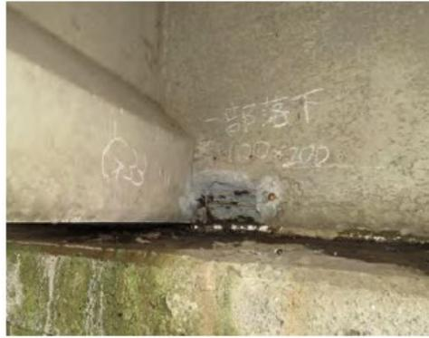
支承沓座モルタルのひびわれ、欠損
