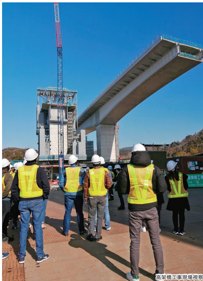
高架橋工事現場視察
