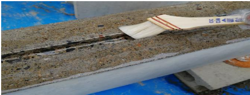
Fig: Applying Primer and NSM CFRP bar
