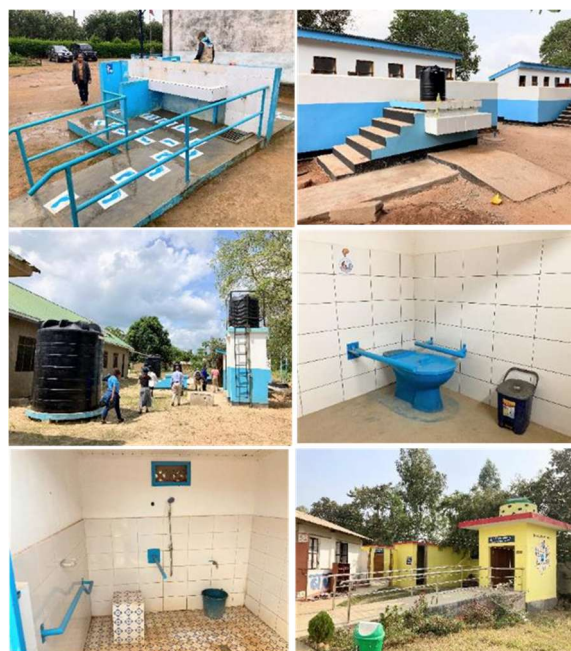
図 8：学校での改善された WASH 施設の例
