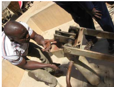
Entretien de pompe par un réparateur
