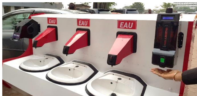
自動手洗い装置。右端で体温を測り使用者をカウントし石鹸が出る。中央の蛇口で流し、左の乾燥機で乾かす。
