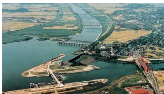
写真：信濃川河川工事事務所、国交省
