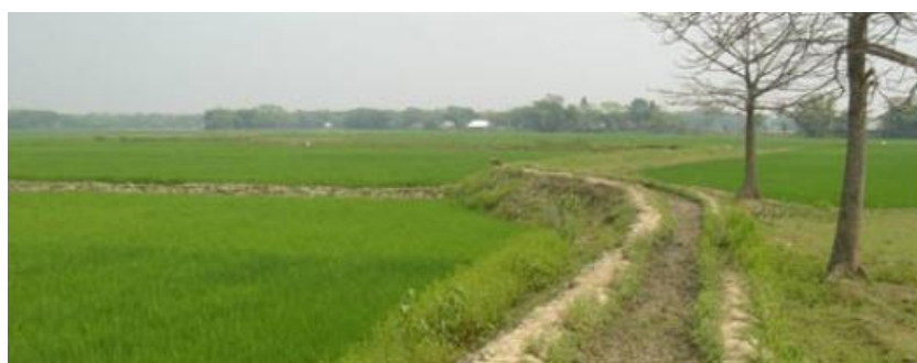
図-2.12 米を洪水から守る潜水堤防（バングラデシュ国ハオール地域）
