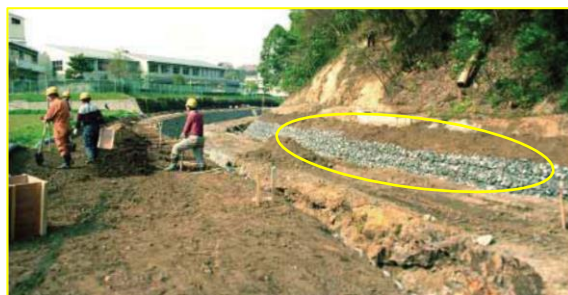
改修工事：右岸は蛇籠護岸とした。
