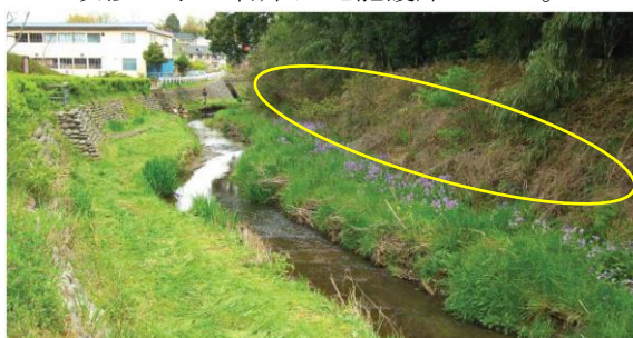
施工後13年経過：斜面林と川の自然的なつながりが保たれている。
