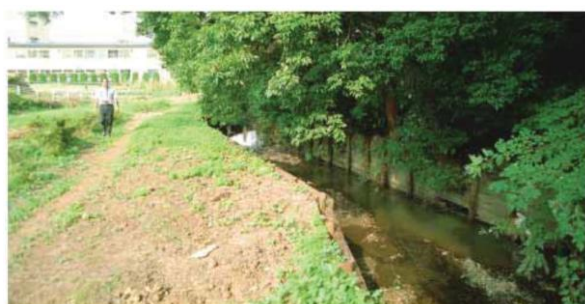
施工前：板柵護岸
