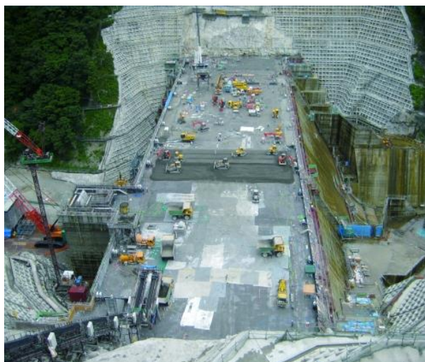
図-3.1 RCD 工法（湯西川ダム）
