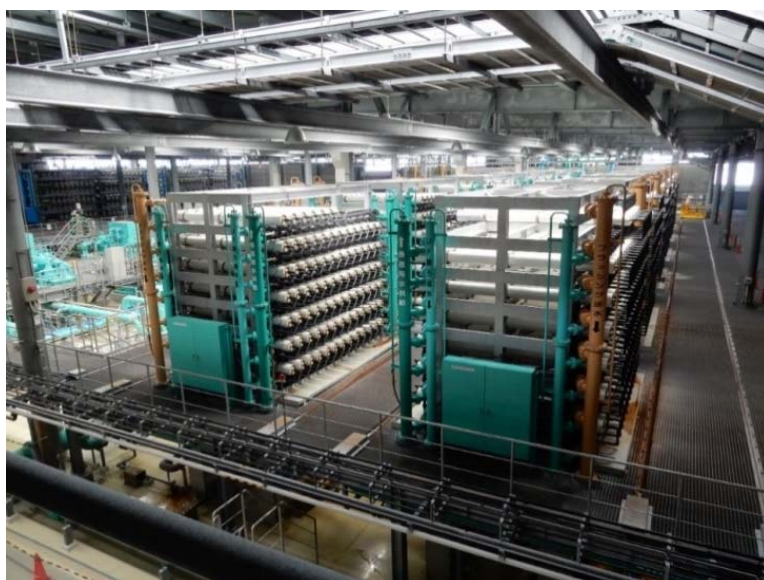
写真4 海の中道奈多海水淡水化センター
