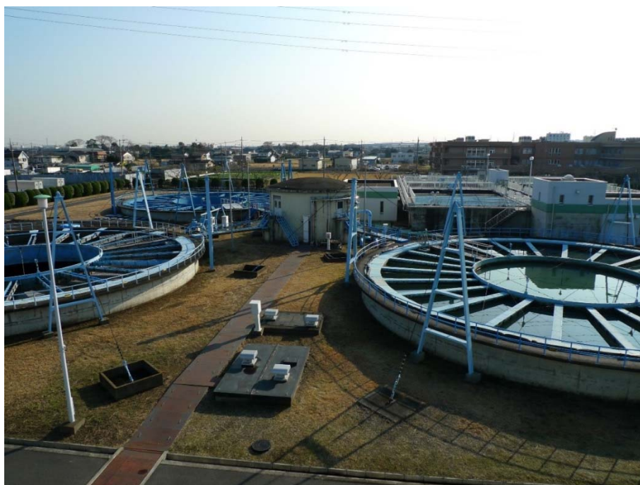
写真2 柿木浄水場 2010年（平成22年）12月22日撮影
