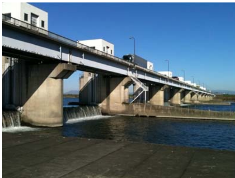
写真4 利根大堰（武蔵水路の取水施設）2010年（平成22年）11月19日撮影
