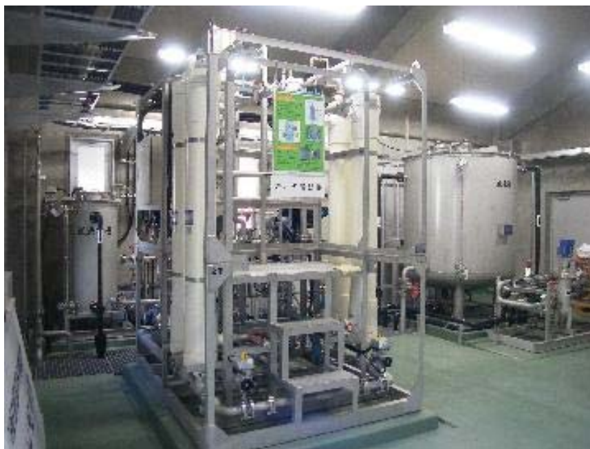
写真9 小規模水道施設の膜処理（京都市墨田地域水道）
