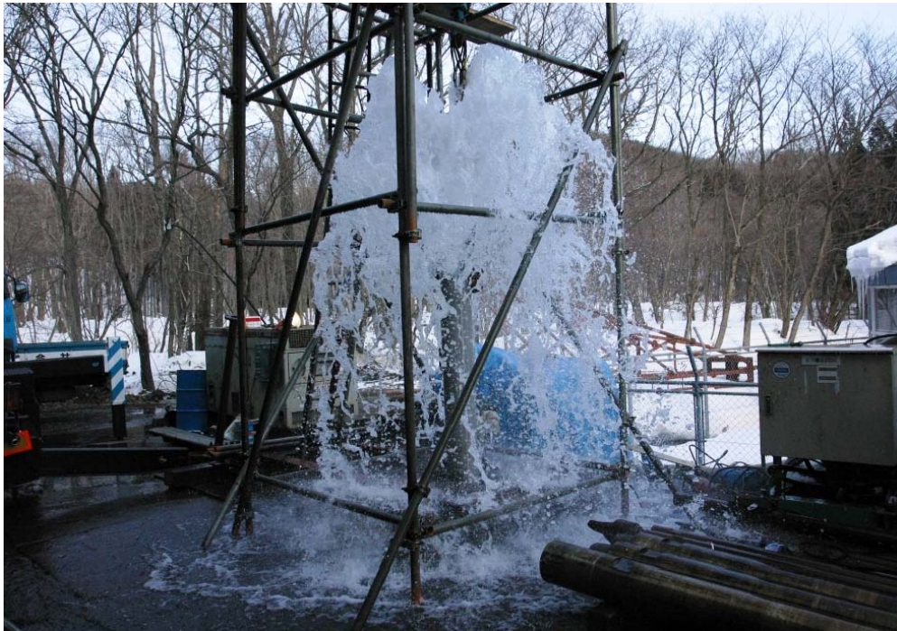
写真 10 岩手県滝沢市 姥屋敷水源 2010年（平成22年）12月2日撮影
