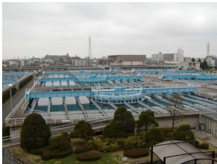
写真2 東京都水道局金町浄水場
