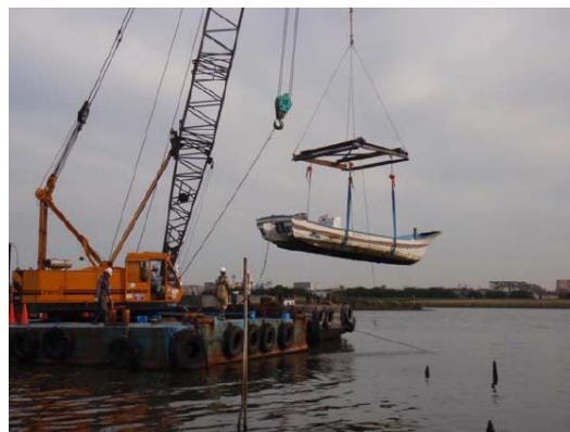
資料：国土交通省関東地方整備局京浜河川事務所
