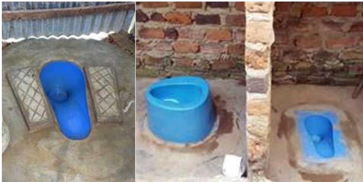
図 6-13 小水量で利用できる LIXIL の SATO Pan 233
