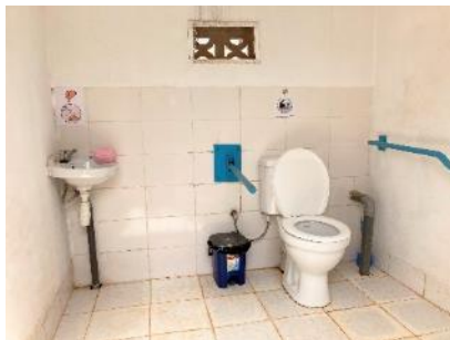
マダガスカル保健医療施設に建設された手すりと便座のある障がい者用トイレ
