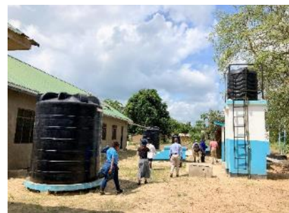
タンザニアの学校に建設された雨水貯留システムと高架水槽
