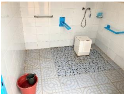
マダガスカル保健医療施設に建設されたシャワールームの内部
