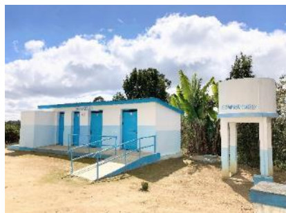
高架水槽の水は、マダガスカルの学校の手洗い施設とトイレに接続
