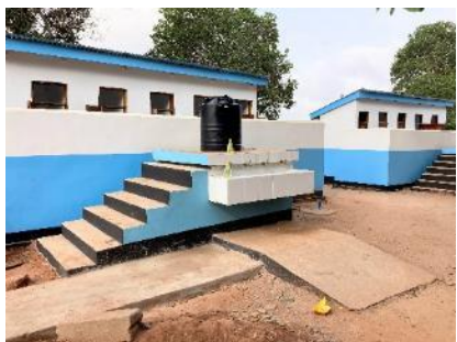
タンザニアの学校のトイレ棟に隣接して設置された手洗い施設
