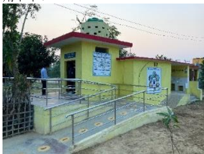
ネパールの保健医療施設に建設された車いす用スロープ付きの障がい者用トイレ
