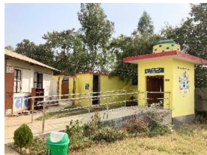
ネパールの学校に建設された車椅子用スロープ付きトイレに設置された高架水槽
