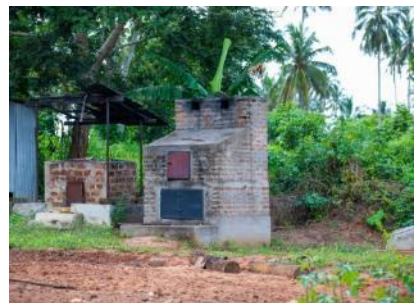
タンザニア保健医療施設に建設された焼却炉
