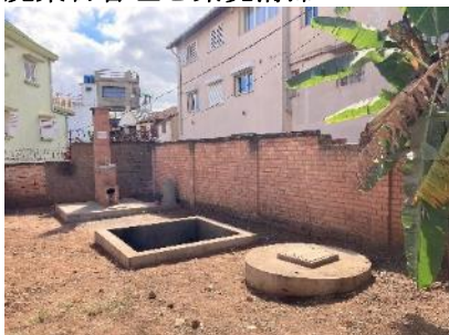
マダガスカル保健医療施設に建設された焼却炉（左）、廃棄物ピット（中央）、プラセンタピット
