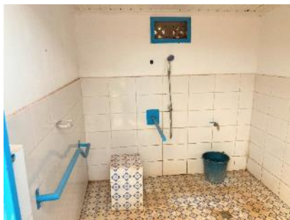
マダガスカルの学校で月経衛生対処のために女子トイレ棟に設置されたシャワー室
