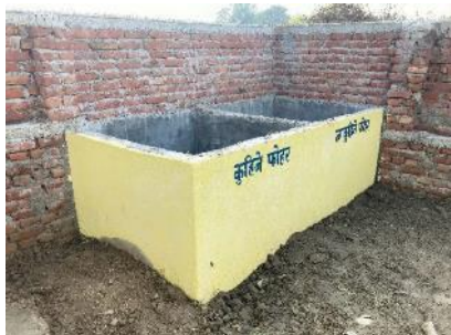
ネパールの学校のゴミ収集・焼却ピット
