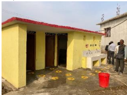
ネパールの学校に設置された手洗い施設付きのトイレ棟
