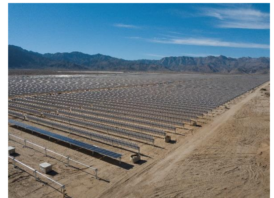
右図：本事業の融資対象3件のうちの1件であるRumorosa Solar（41MW。バハカリフォルニア州）の太陽光発電設備
