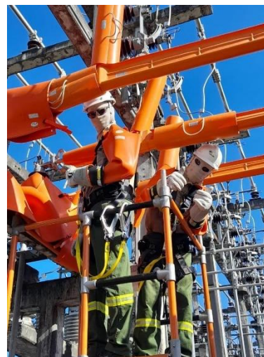
写真： 配電設備のメンテナンス を行うCoelbaの職員
