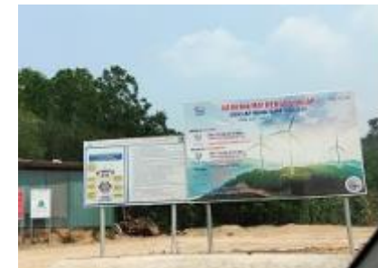
建設サイトの様子
