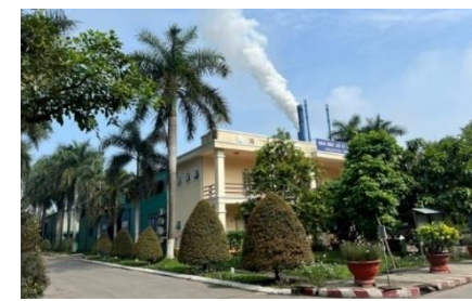
廃棄物焼却炉の写真
