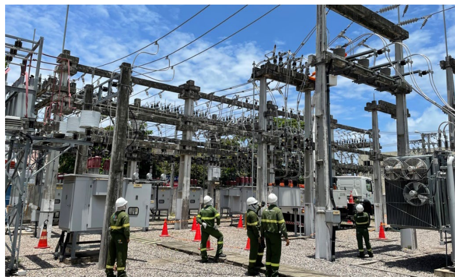
変電所の点検・改修を行うCELPEの職員
