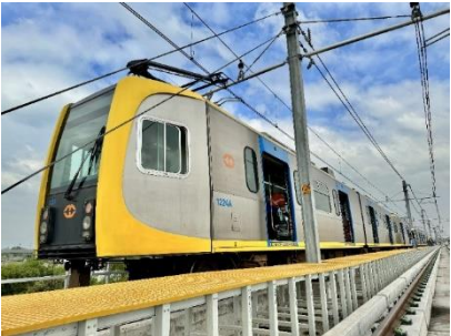
延伸区間を試験走行する車両
